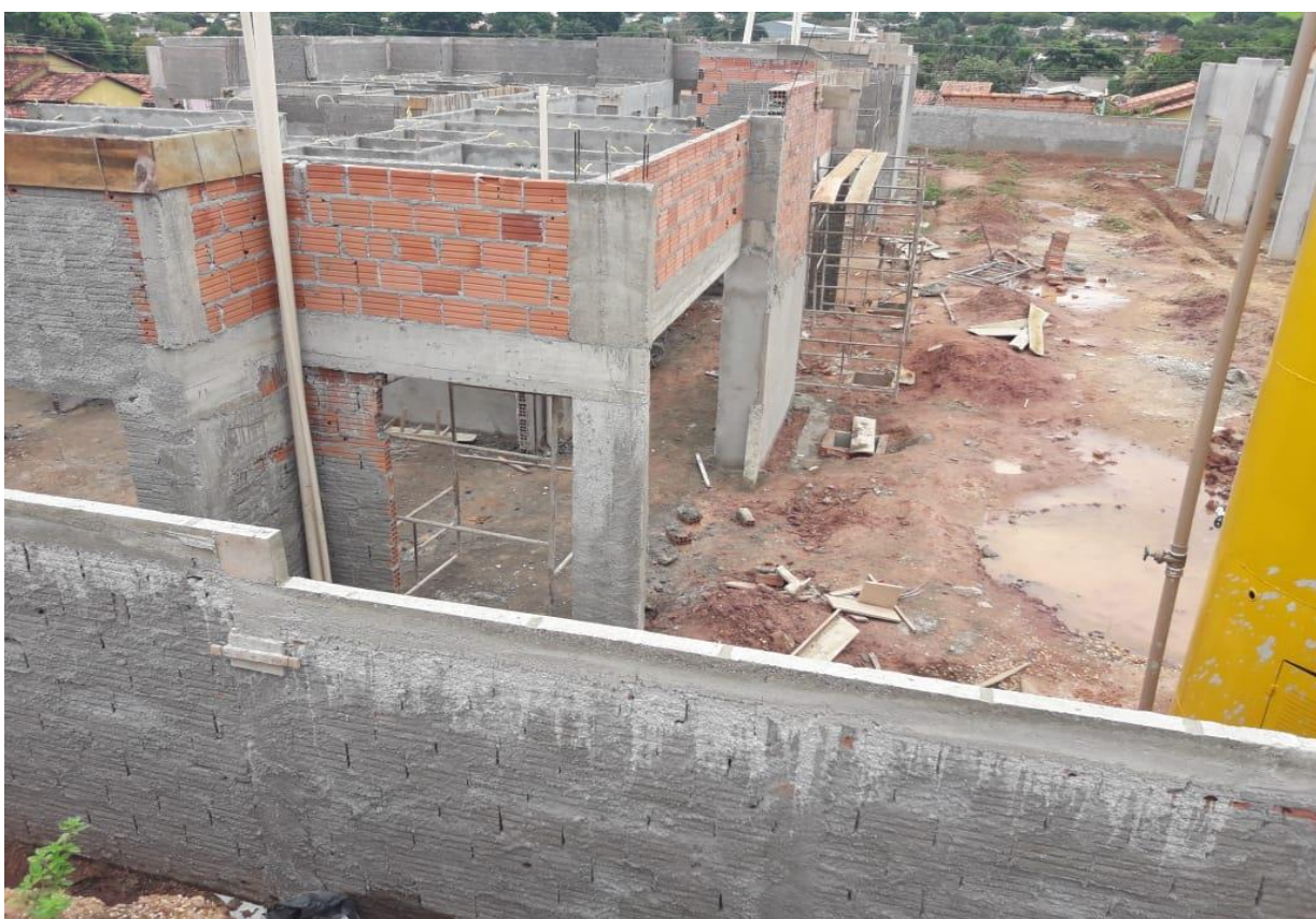
Documentos da retomada da obra em anexo.
